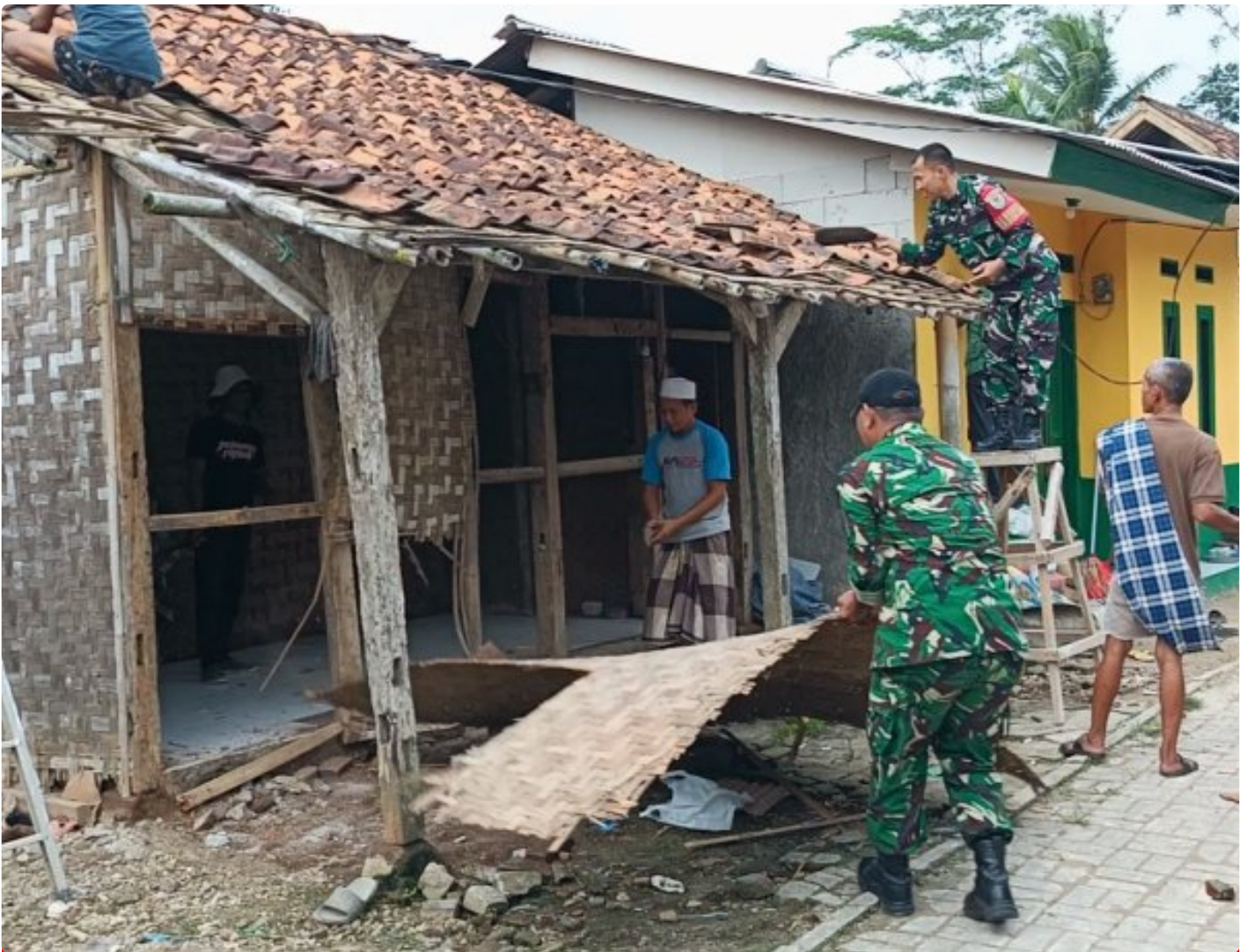
Pembongkaran Rumah Bapak Narmin
